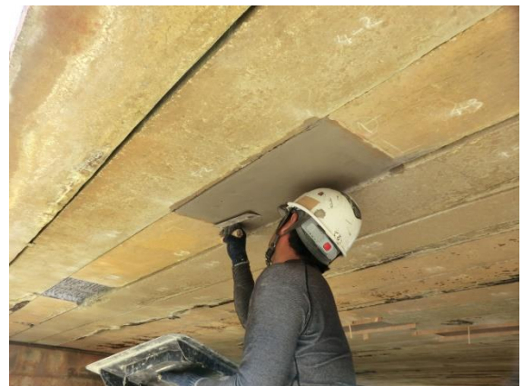
[写-6-10 左官による仕上げ作業状況]
