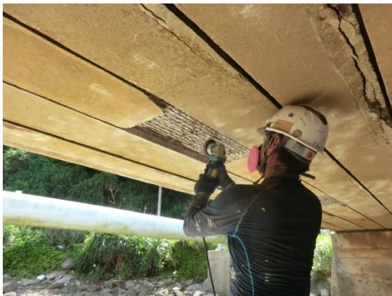
[写-6-7 ケレン作業状況]
