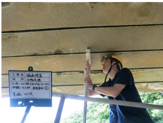
[写-6-1 着磁作業状況]
