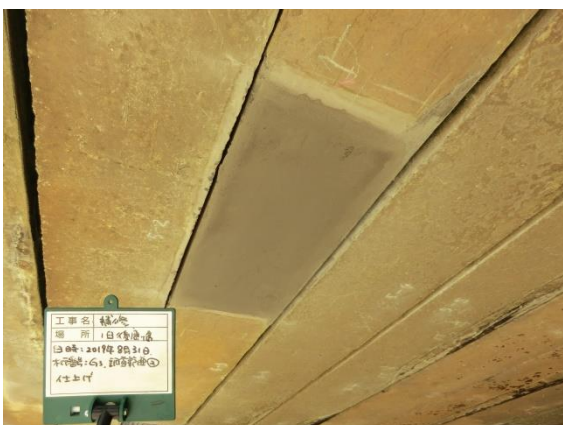
[写-6-11 復旧作業完了]
