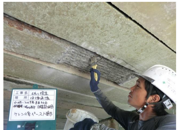
[写-6-8 防錆材ペースト塗布状況]
