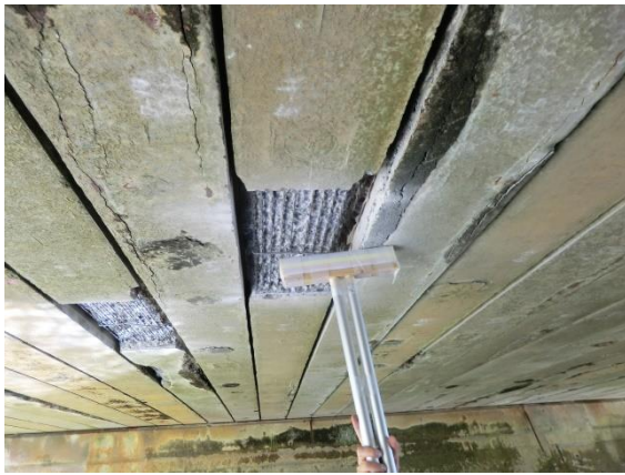
[写-6-5 研り後再着磁作業状況]
